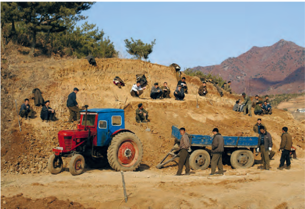
Arbeiders leggen een weg aan in Unjon. Foto Martin Tutsch
